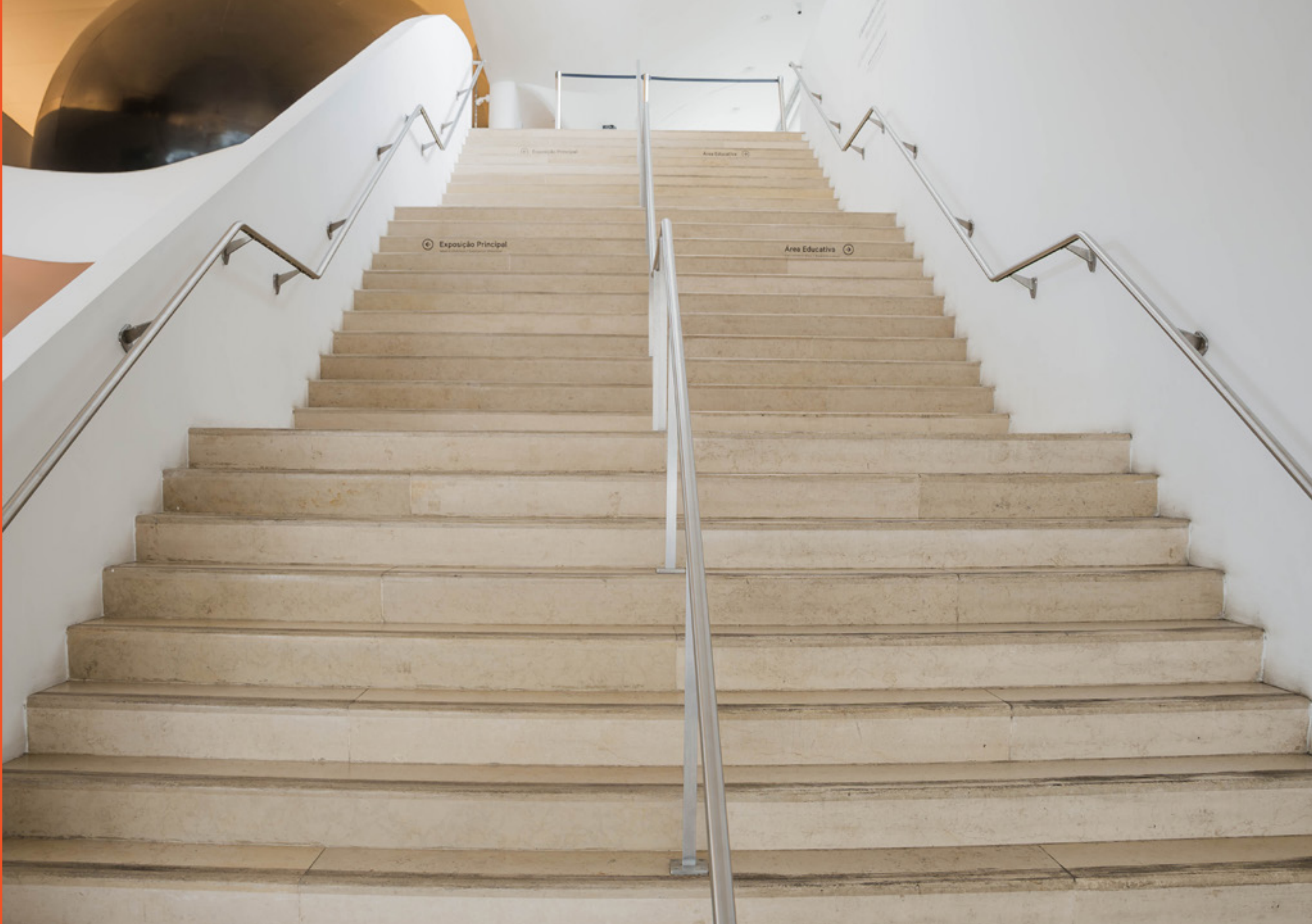
Fotografia das escadas.
